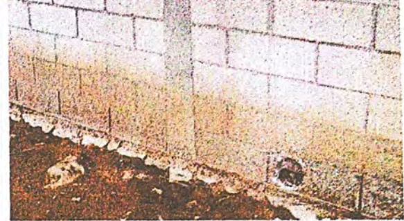
Foto 2: El Centro Educativa se requiere el cambio de paredes y ampliaciones de aulas.
