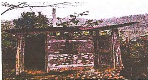
Foto 5: Se necesita los cambios estuctruas de sanitarios del Centro Educativa.
